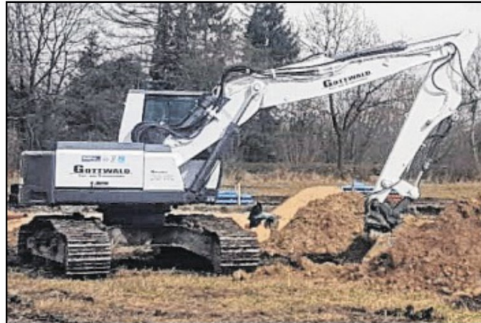
Bevor es an den Hausbau geht, sind die Bagger an der Reihe.
